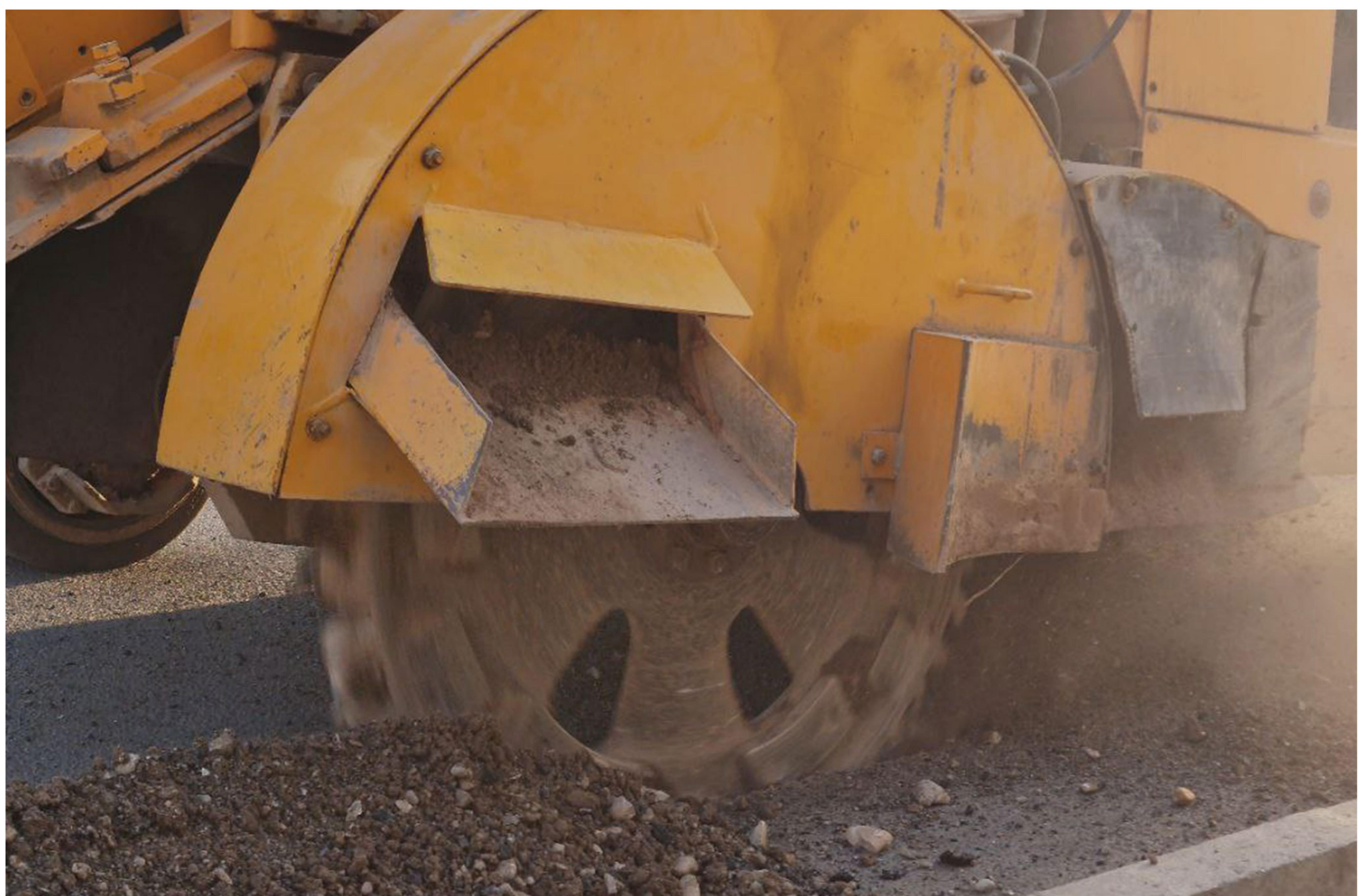
نصب شده است، اثرباریک شیارباریک بازسازی شده و آسفالت شده به سختی قابل مشاهده است. برای موفقیت آمیز بودن اجرای پروژه با روش میکرو ترنچینگ که هنوز با وجود قدیمی بودن ساختار تکنولوژی یک فرآیند نسبتاً جدید است، کارگران باید کاملاً آموزش دیده و تمام موارد ایمنی پروژه HSE رعایت شده و با تکنیک نصب مناسب و همچنین استفاده از اجزای صحیح در پروژه استفاده کنند. در غیراین صورت، شیار خطی می‌تواند ریزش کرده یا باز شود، که منجر به تعمیرات پرهزینه مجدد می‌شود.
