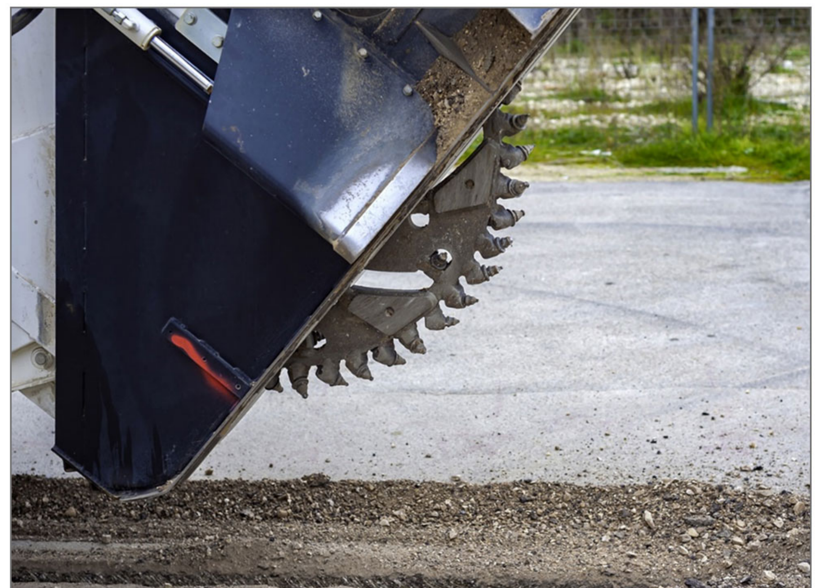
شبکه‌های فیبرنوری نیاز به احداث چند صد کیلومتری کانال‌های فیبرنوری برای محافظت از کابل‌های فیبرنوری دارند. این مجاری محافظ، معمولاً با یک ماشین ترنچر، به سرعت حفاری و به صورت شیارخطی ایجاد می‌شوند.
